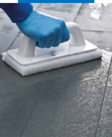
Czyszczenie i profilowanie fug pacą typu Scotch-Brite®
