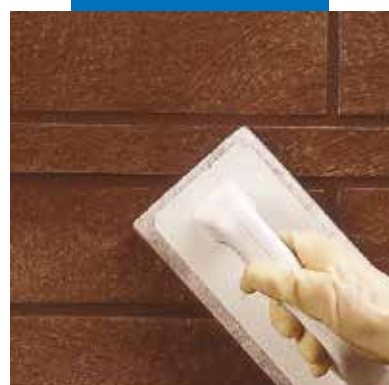
Czyszczenie spoin za pomocą Scotch-Brite® (zaprawa częściowo stwardniała)
