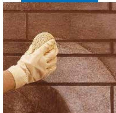
Czyszczenie i profilowanie fug gąbką
