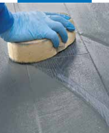
Przykład wykonania okładzin w łazience przy użyciu płytek gresowych; fugi na podłodze i ścianie wykonane zaprawą Ultracolor Plus
